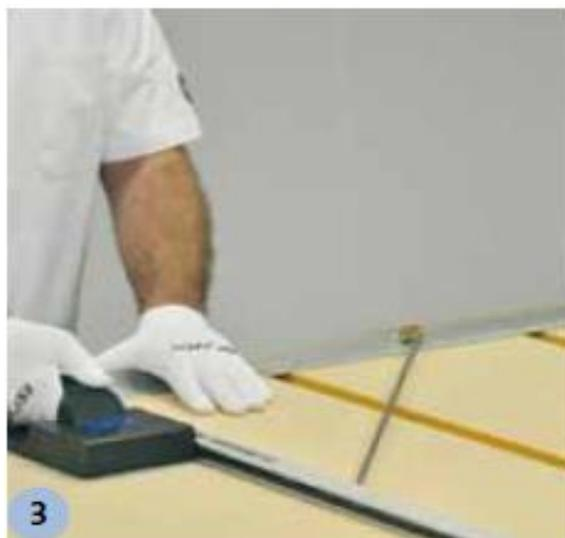
4. Retirar o excesso de lã da aba utilizando o estilete.
